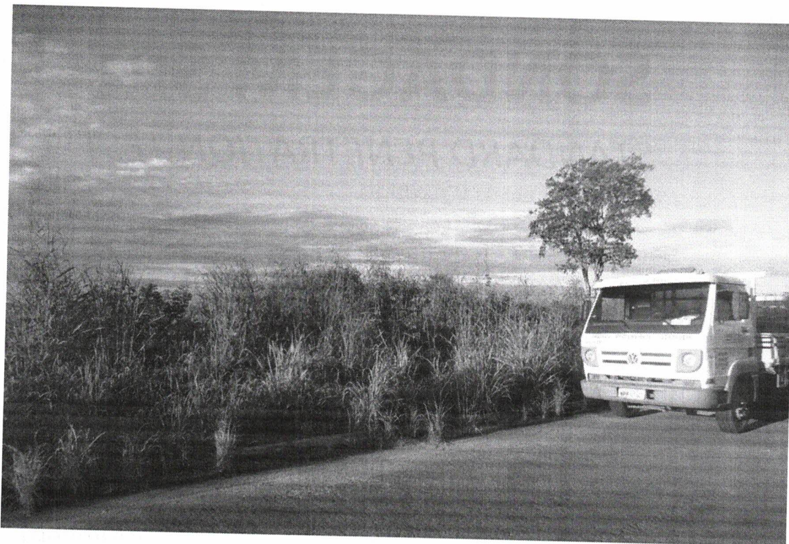
EXECUÇÃO DE SONDAgens NO LOCAL
